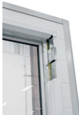
Infästning plåtvinkel
